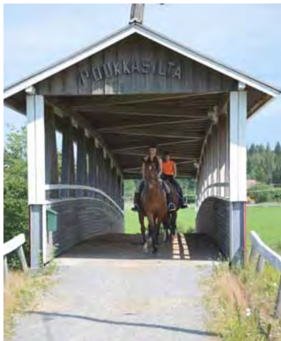
▲ Ratsukot Poukkasillalla Loimijokea ylittämässä. Kuva: Hippolis, Sirpa Korhonen
